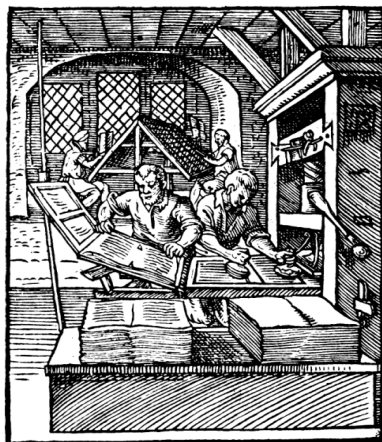
เครื่องพิมพ์ในช่วงปลายยุคของยุโรปสมัยกลางที่มีความสามารถในการพิมพ์ได้กว่า 3600 หน้าต่อวัน (ภาพจาก en.wikipedia.org/wiki/Printing_press )
